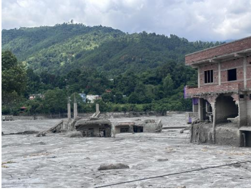
Dans le district de Rasuwa après la crue dévastatrice du 26 août 2026 © SOS Villages d'Enfants au Népal
